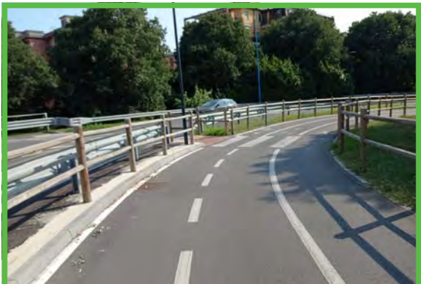
Curvatura della rampa discendente del sottopasso ciclabile, via Volturmo.
