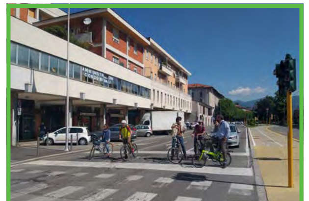
Casa avanzata all'intersezione semaforizzata di Piazza Cesare Battisti.
