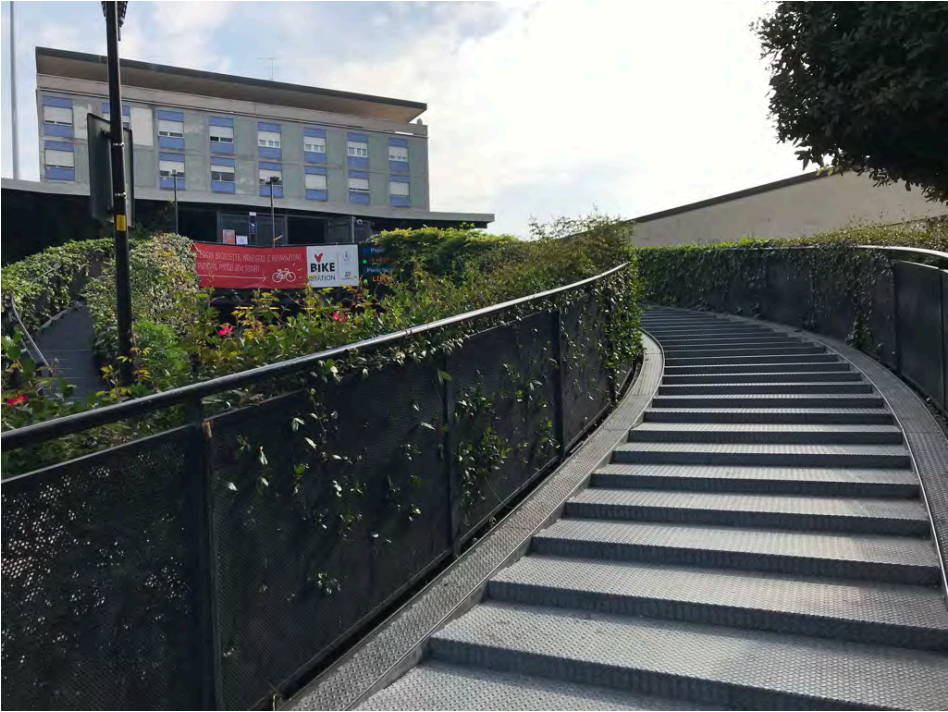
Scalinata di accesso al primo piano della bike starion con canaline ai lati per salita e discesa.
