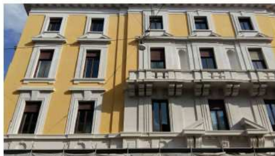
Foto 113 – prospetto ovest centrale – durante lo smontaggio dei ponteggi
