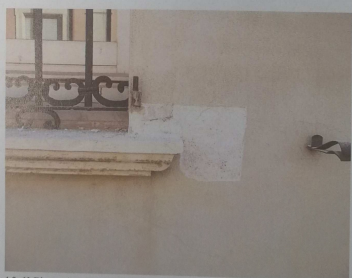
15. Il Piano, intonaci dell'ultimo intervento di ristrutturazione.
