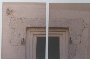
2, 3. 1 Piano, demolizioni integrate con malte cementizie.
