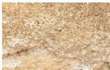
Fig. 5) Dettaglio dell'intonaco attuale.
