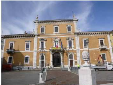
Foto 1 – prospetto est prima del montaggio dei ponteggi
