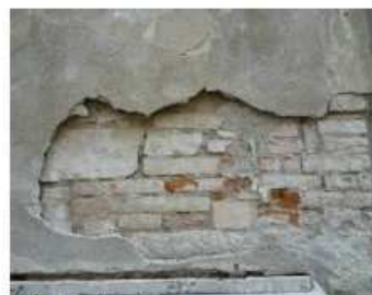
6. Prospetto ovest, muratura mista.
