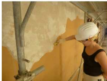
Foto 33 - rimozione rasatura superficiale
