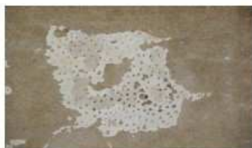
Fig. 6) Livello originario picchettato, utilizzato come substrato.
