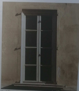
1. 1 Piano, integrazione degli intonaci lungo i contorni.
