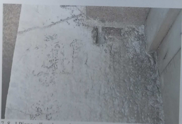
7, 8. I Piano, alloggiamenti per le grappe metalliche delle spalle.
