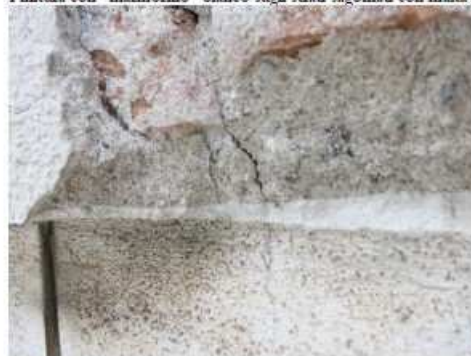
Particolare dello spessore del "marmorino" e degli strati sottostanti.
