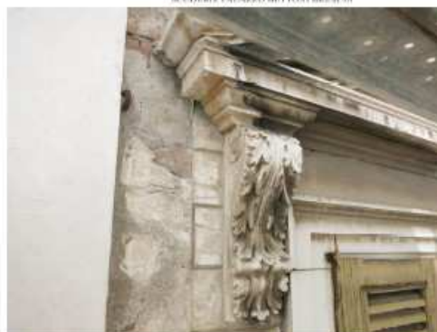
Particolare del dilavamento ai lati delle finestre.
