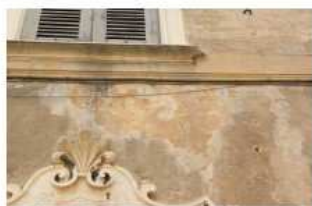
Fig. 2) Decorazione lapidea e marcapiano d'intonaco.
