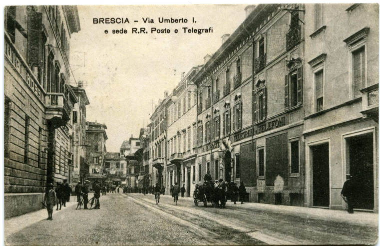
Via Umberto I, ora via Gramsci dopo i lavori di allargamento e rettifica – fine 1800
