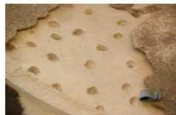
Fig. 7) Livello originario picchettato, visibile in una lacuna.
