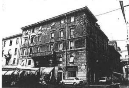
VEDUTA DI INSIEME DELL'IMMOBILE
