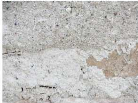
In stratigrafia: muro in mattoni, rasatura fine chiara, strato di malta grigia a granulometria grossa già con le incisioni a definire la sagoma e come strato finale un "marmorino" a imitazione del Borticino.
