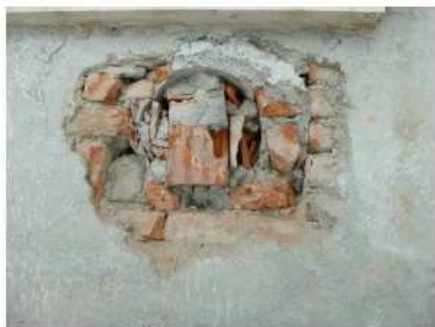
Foto 38 - rimozione tamponature incongrue
