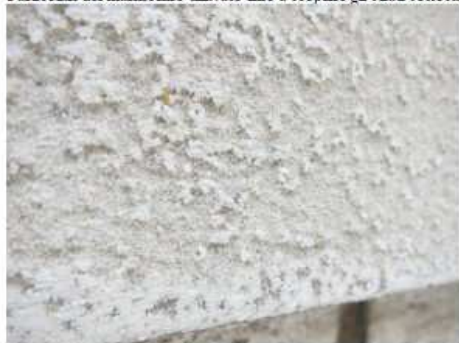
Particolari del marmorino dilavato fino a scoprire gli strati sottostanti.
