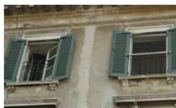
19. Prospetto esterno ovest, tracce della prima coloritura.
