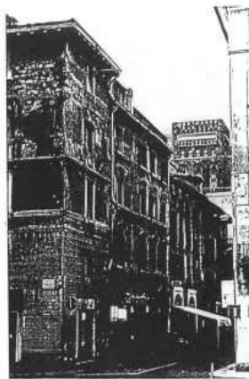
FACCIATA PROSPETTANTE SULLA VIA PADRE GIULIO BEVILACQUA
