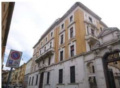
Foto 71 - Prospetto ovest su via Porcellana - vista da sud
