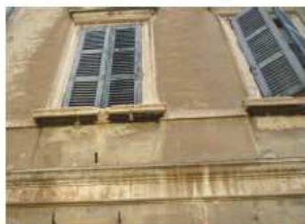
12. Prospetto nord, davanzali in calcare bianco, contorni delle finestre e marcapiano eseguiti in stucco imitativo della pietra.
