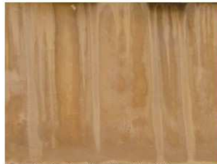
Foto 5 – percolamenti e alterazioni cromatiche superfici intonacate
