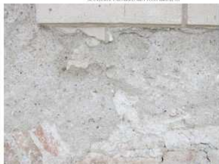
In stratigrafia: muro in mattoni, rasatura fine chiara, strato di malta grigia a granulometria grossa già con le incisioni a definire la sagoma e come strato finale un "marmorino" a imitazione del Borticino.
