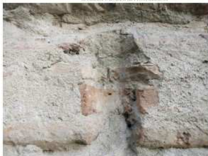
Particolare delle file dei mattoni a sbalzo.
