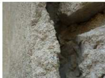
9. Arriccio preparatorio e intonaco di finitura.
