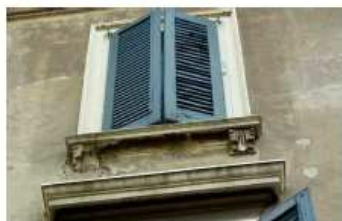
11. Prospetto ovest, mensola a foglia d'acanto delle finestre del secondo piano eseguite in stucco imitativo della pietra.
