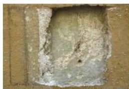
18. Corte interna, prospetto verso ovest, primo livello di coloritura, nascosto dai rivestimenti neoclassicisti.
