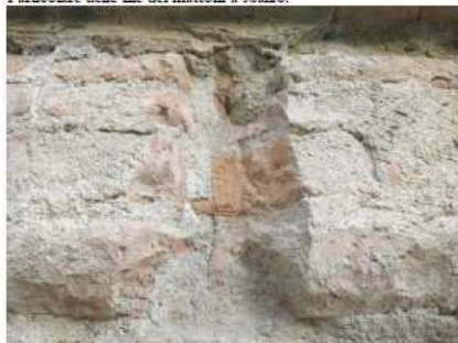
Particolare dei mattoni rotti con lo scalpello a definire il bugnato. Le file sono state realizzate intere e definite dopo a misura.
