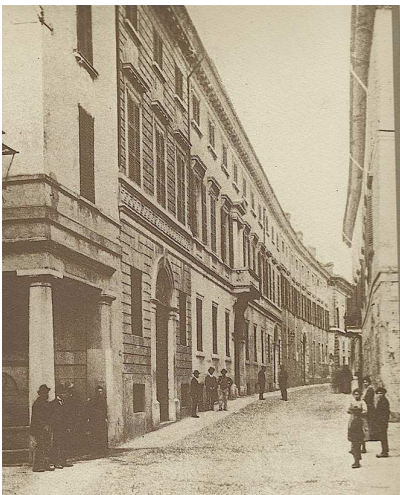
Via Tosio dopo i lavori di allargamento e rettifica – fine 1800
