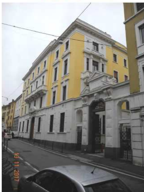
Foto 111 – prospetto ovest visto da sud
