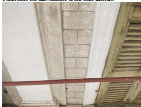
Particolare del dilavamento ai lati delle finestre.
