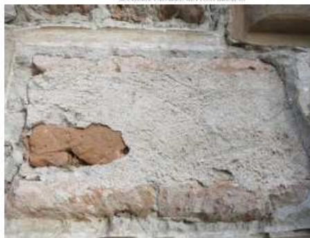
Rasatura a granulometria sottile stesa sui mattoni come prima "finitura".
