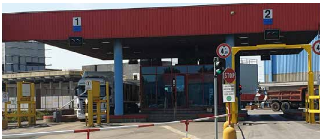
Ingresso-pesa con portale per il controllo radioattività
