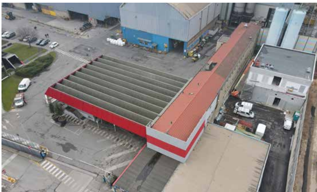
Lavori per la costruzione dell'impianto recupero calore
