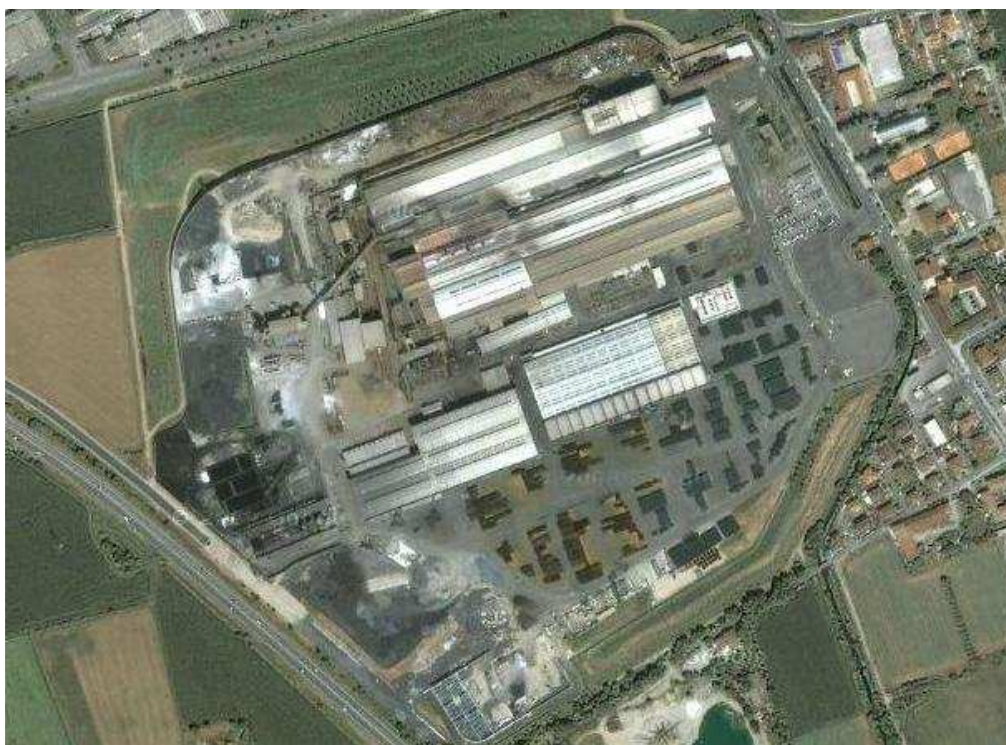
Figura 13 Dettaglio dello stabilimento riferito all'anno 2007
